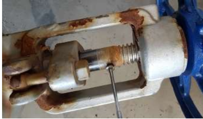
بررسی وضعیت فولاد زنگ نزن ۳۱۶ مورد استفاده در STEM و لبه دیسک
