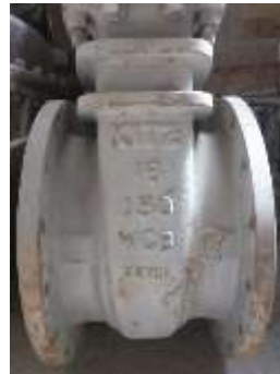
نمونه ای از مارکینگ روی بدنه شیر KITZ چینی
