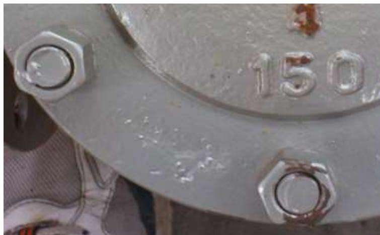
پیچ و مهره متفرقه فاقد مارکینگ از میلگرد آهنی معمولی - مردود
