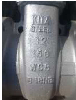
نمونه ای از مارکینگ روی بدنه شیر KITZ چینی
