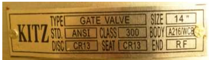
نمونه ای از مارکینگ روی بدنه شیر KITZ چینی
